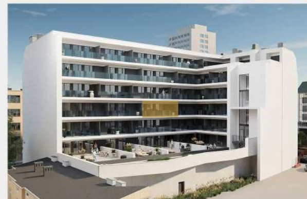
Rzut budynku od strony wewnętrznej
